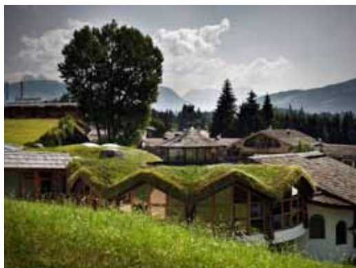
Aus baubiologischen Gründen gibt es beim Stanglwirt nur Gras- und Schindeldächer.
