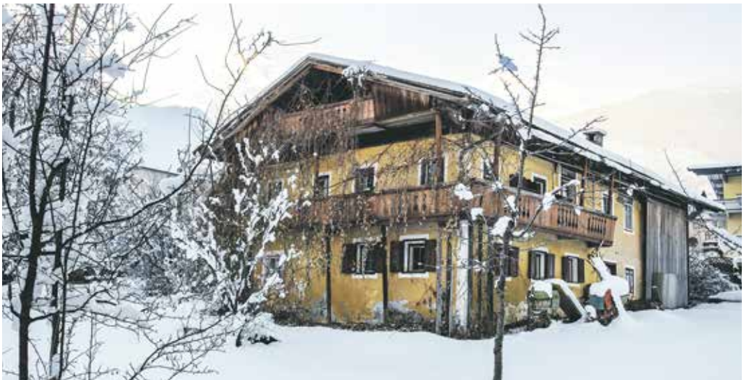
Das „Orgelerhaus“ in Fügen/Kapfing wurde inzwischen abgerissen. In der Nähe erinnert ein Denkmal an Mauracher.
