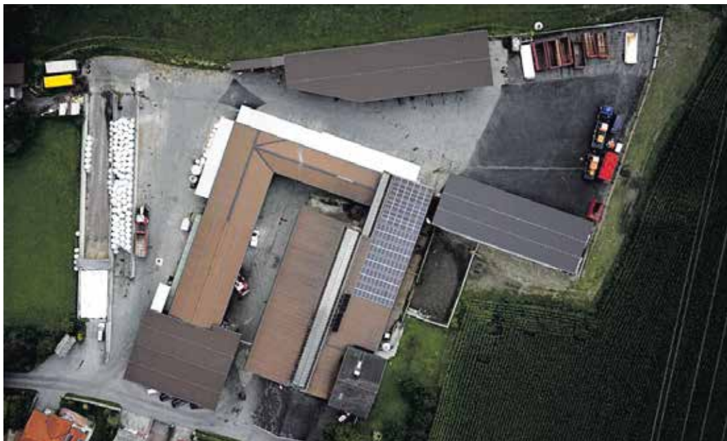
Die Hofstelle des Stadtlerhofes umfasst 14.000 m 2 , ein Teil der 5.600 m 2 Dachfläche wird als Kollektorfläche für die Photovoltaikanlage verwendet. Bild: Gumpitsch
